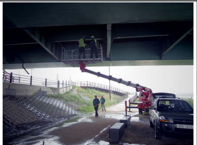
고소차를 이용한 상부비파괴 시험
