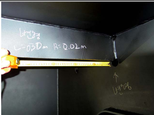
거더내부 G2-S09 상면 리브변형 D=20\text{mm} , L=0.3\text{m}
