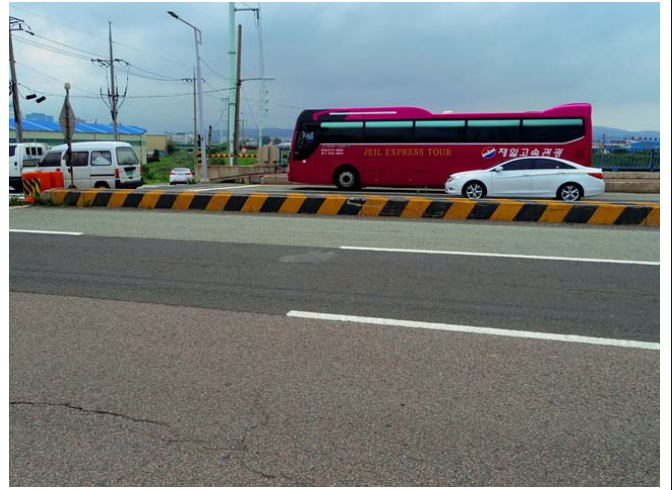
교면포장 운동장방향 S10 포트홀 보수
