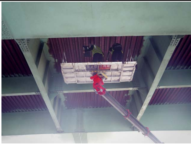
바닥판하면 외관 조사
