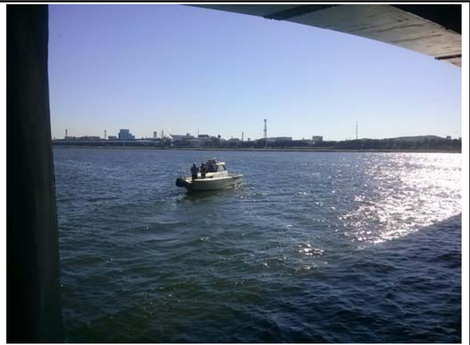
보트를 이용한 외관조사
