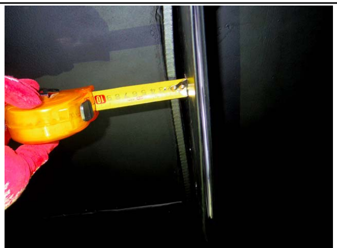
거더내부 G2-S09 상면 리브변형 D=10\text{mm} , L=0.4\text{m}
