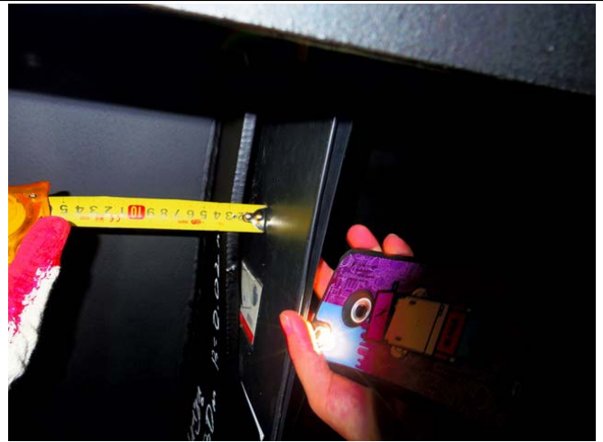
거더내부 G2-S09 상면 리브변형 D=20\text{mm} , L=0.3\text{m}
