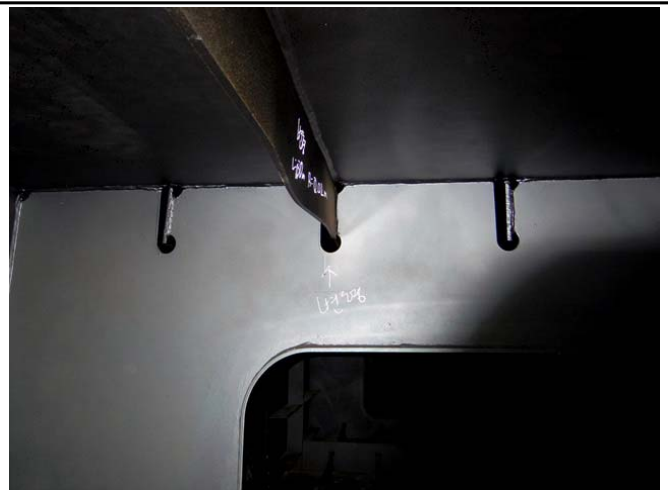
거더내부 G2-S09 상면 리브변형 D=20\text{mm} , L=0.3\text{m}
