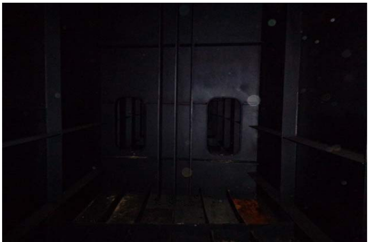
거더 내부 전경
