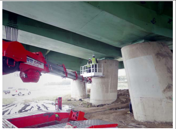
점검차를 이용한 외관조사(바닥판하면)
