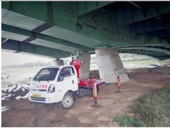
점검차를 이용한 외관조사(바닥판하면)
