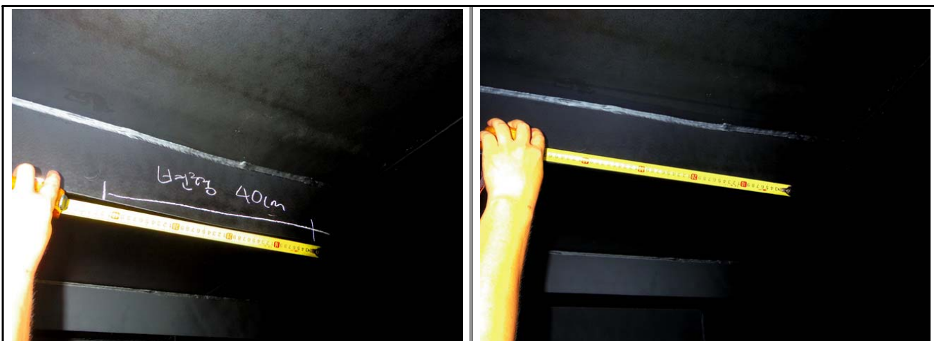
거더내부 G2-S09 상면 리브변형 D=10\text{mm} , L=0.4\text{m}
