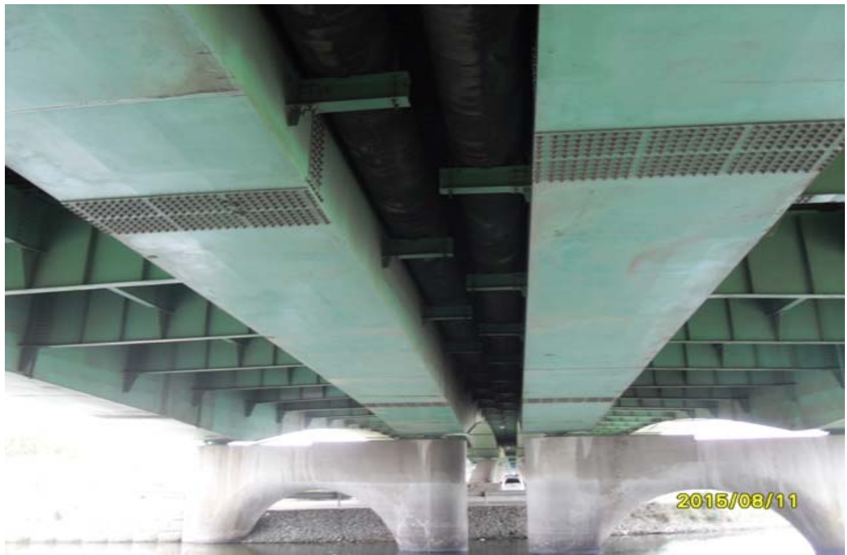
바닥판하면 및 거더 외부 전경
