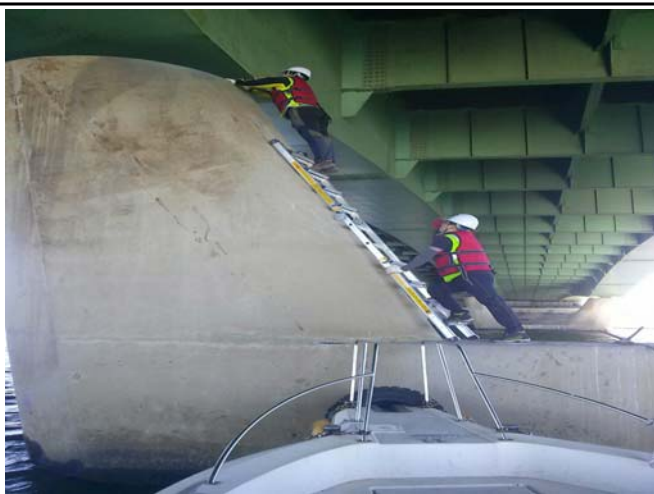
사다리를 이용한 외관조사
